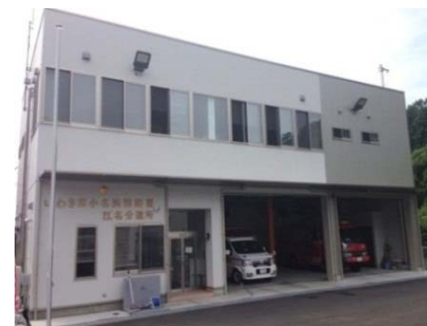
消防庁舎復旧事業 (いわき市消防本部 小名浜消防署江名分遣所)
