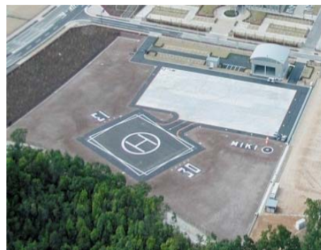
救助活動等拠点施設 (提供: 兵庫県広域防災センター)
