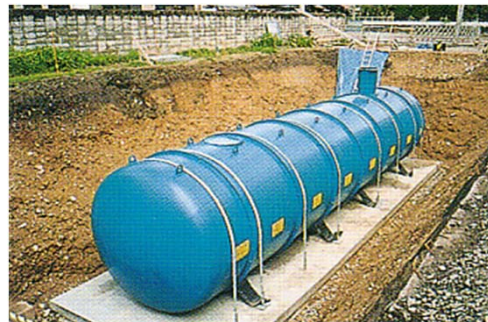
耐震性貯水槽
